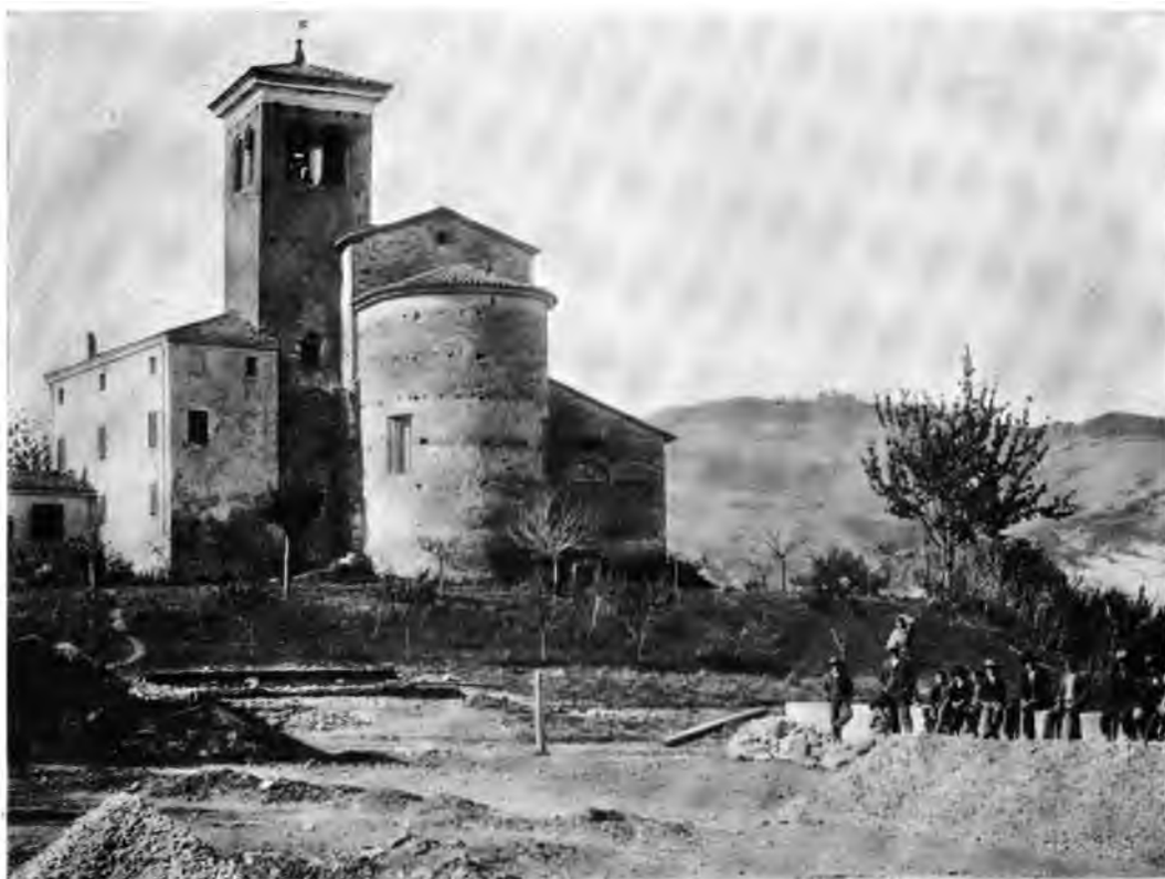
FONTANA ELICE — ABSIDE DELLA CHIESA PARROCCHIALE.
